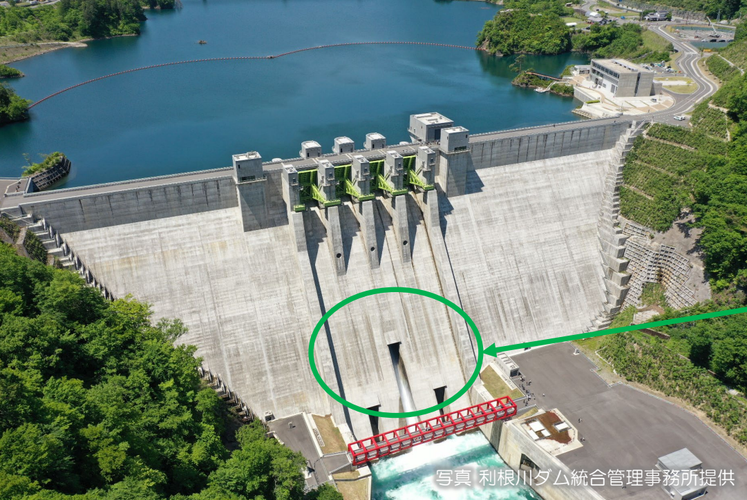
↑コンジットゲート常用洪水吐設備 コンジットゲートはダム堤体内に 3基設置。その中のひとつを見学
