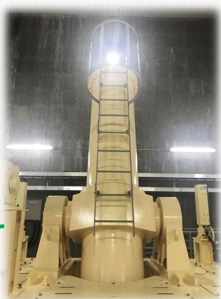
↑コンジットゲート常用洪水吐設備 コンジットゲートはダム堤体内に 3基設置。その中のひとつを見学
